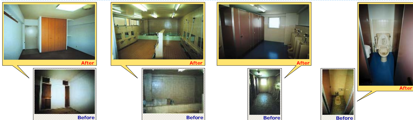
S社行徳寮改修
