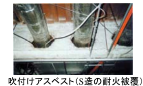
吹付けアスベスト(S造の耐火被覆)
